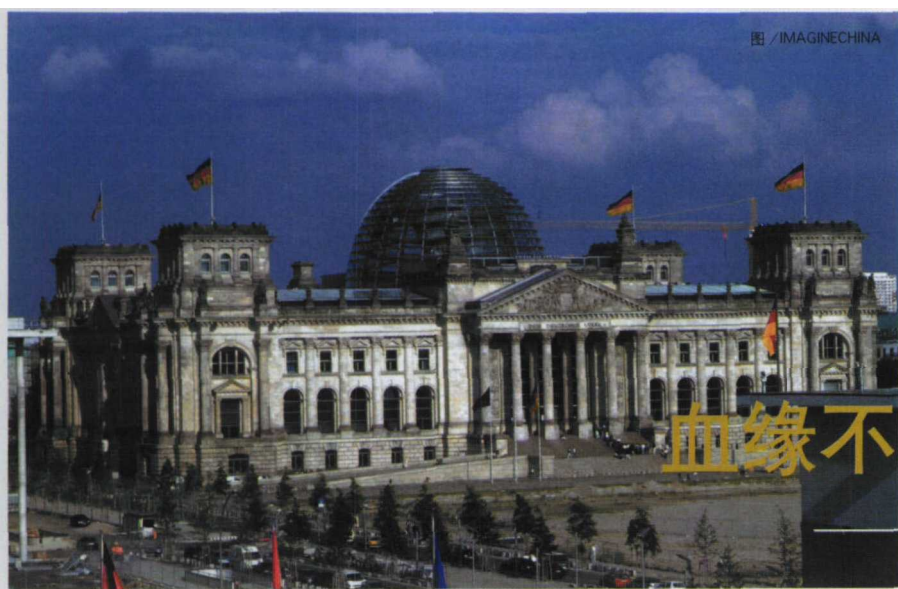
重建后的德国国会大厦
